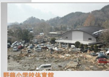
野蒜小学校体育館
