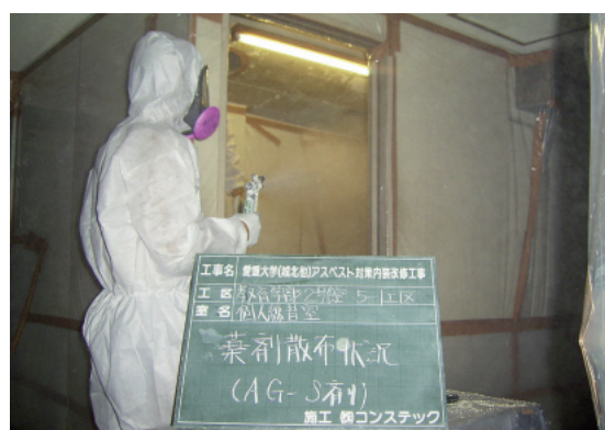
薬剤散布状況
